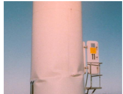
Abbildung 5: Beispiel für Schalenbeulen bei einer Windenergieanlage
